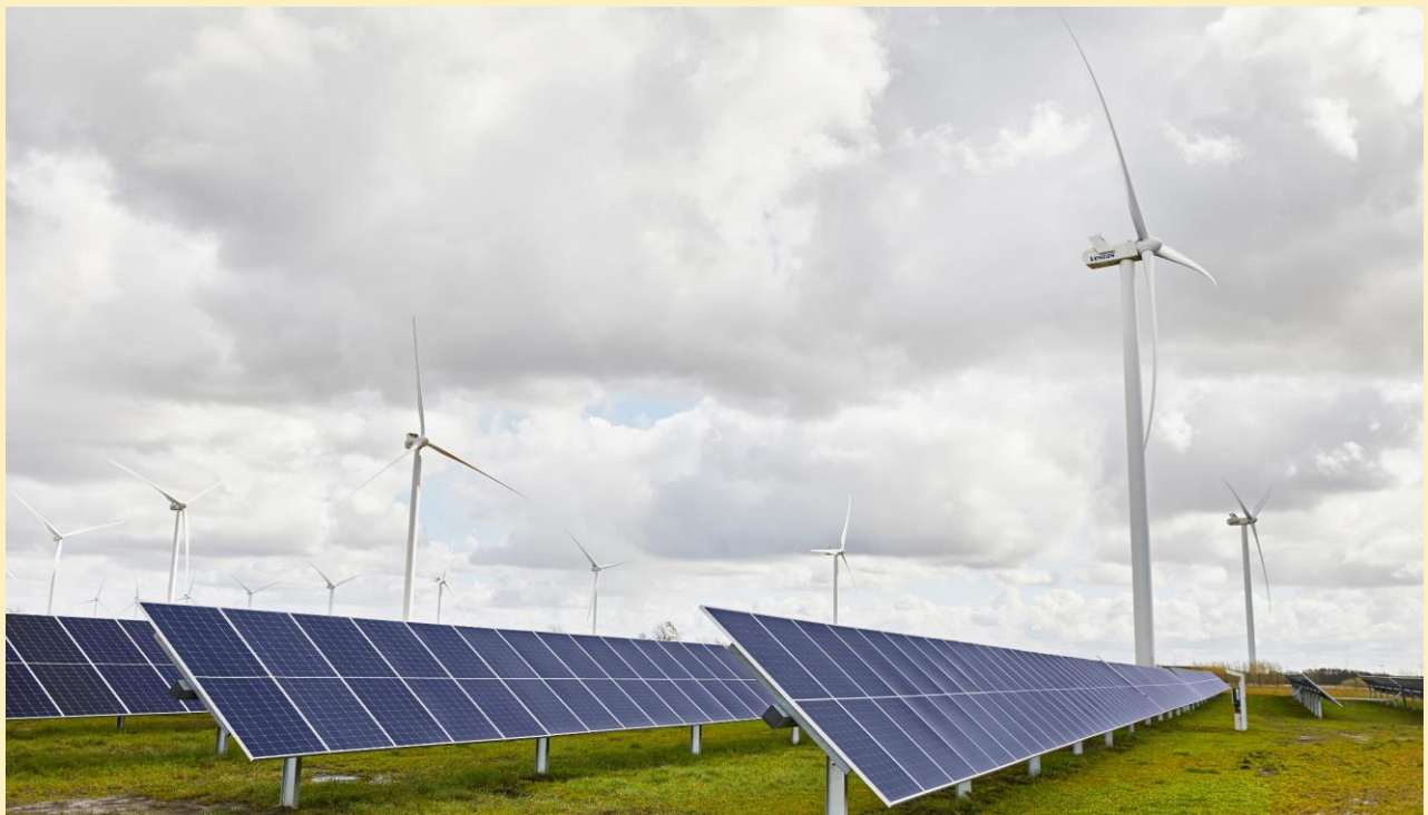
Figur 7: Foto fra eksisterende hybridanlæg.
